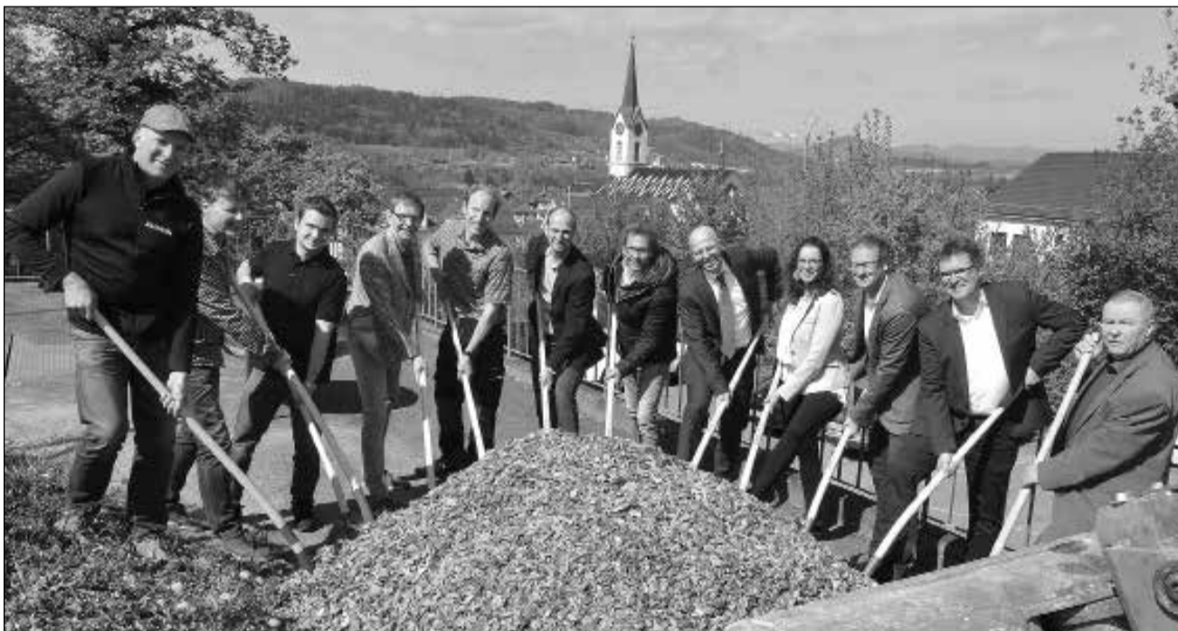
Gemeindeammann Kurt Diem (rechts) und Gemeinderat Stephan Schibli (4. v. links) mit Ortsbürgergemeinde-FiKo-Präsident Urs Fischer (2. v. rechts), Förster Guido Schibli (5. v. links), Planern, Kunden und Wärmeabnehmern am letzten Donnerstag beim Spatenstich zum neuen Wärmeverbund beim Schulhaus in Stetten. Foto: bg
