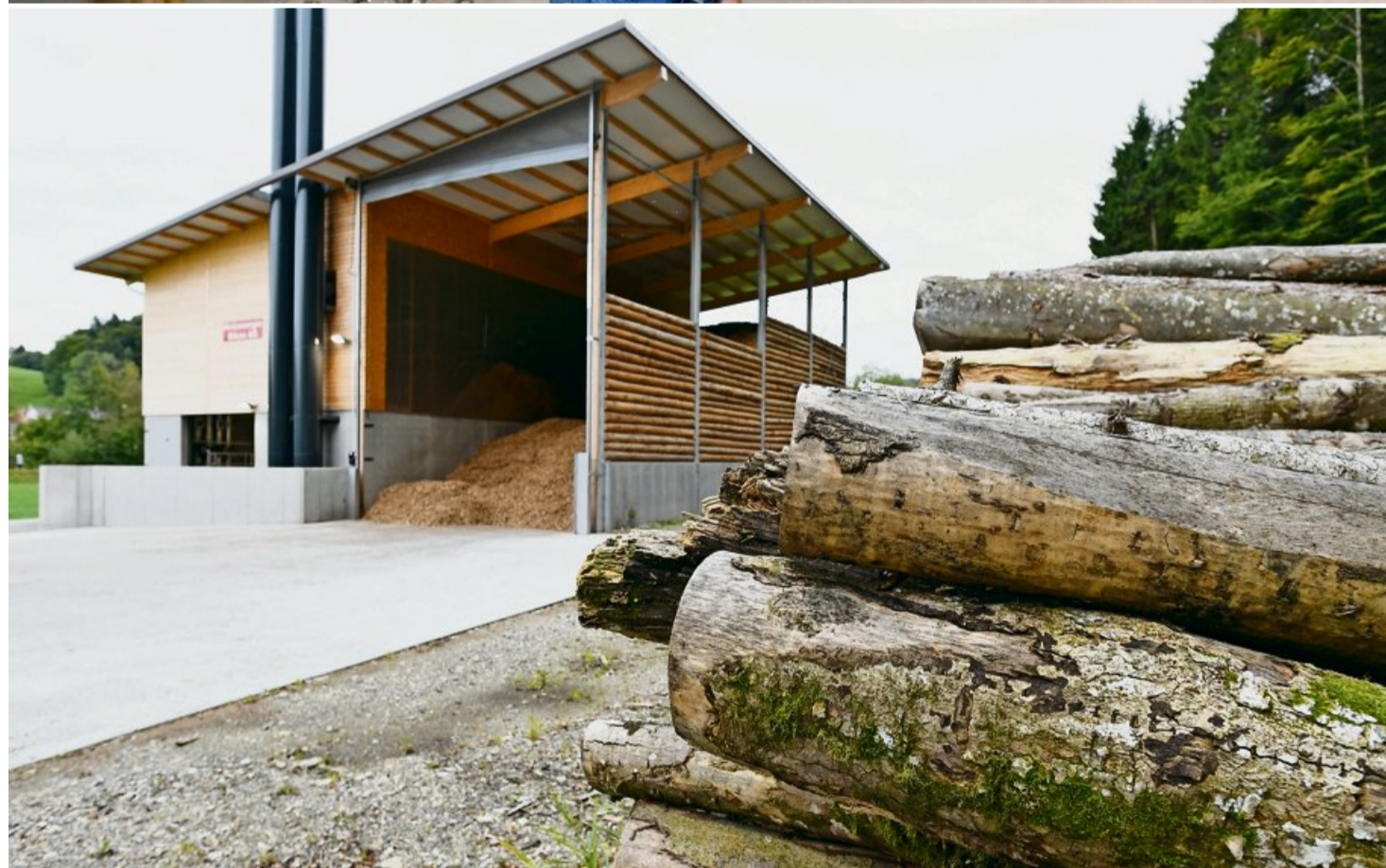
Emil Ott, Präsident der Holzenergie Rikon AG, präsentiert den neuen Wärmeverbund im Zeller Ortsteil Rikon.
